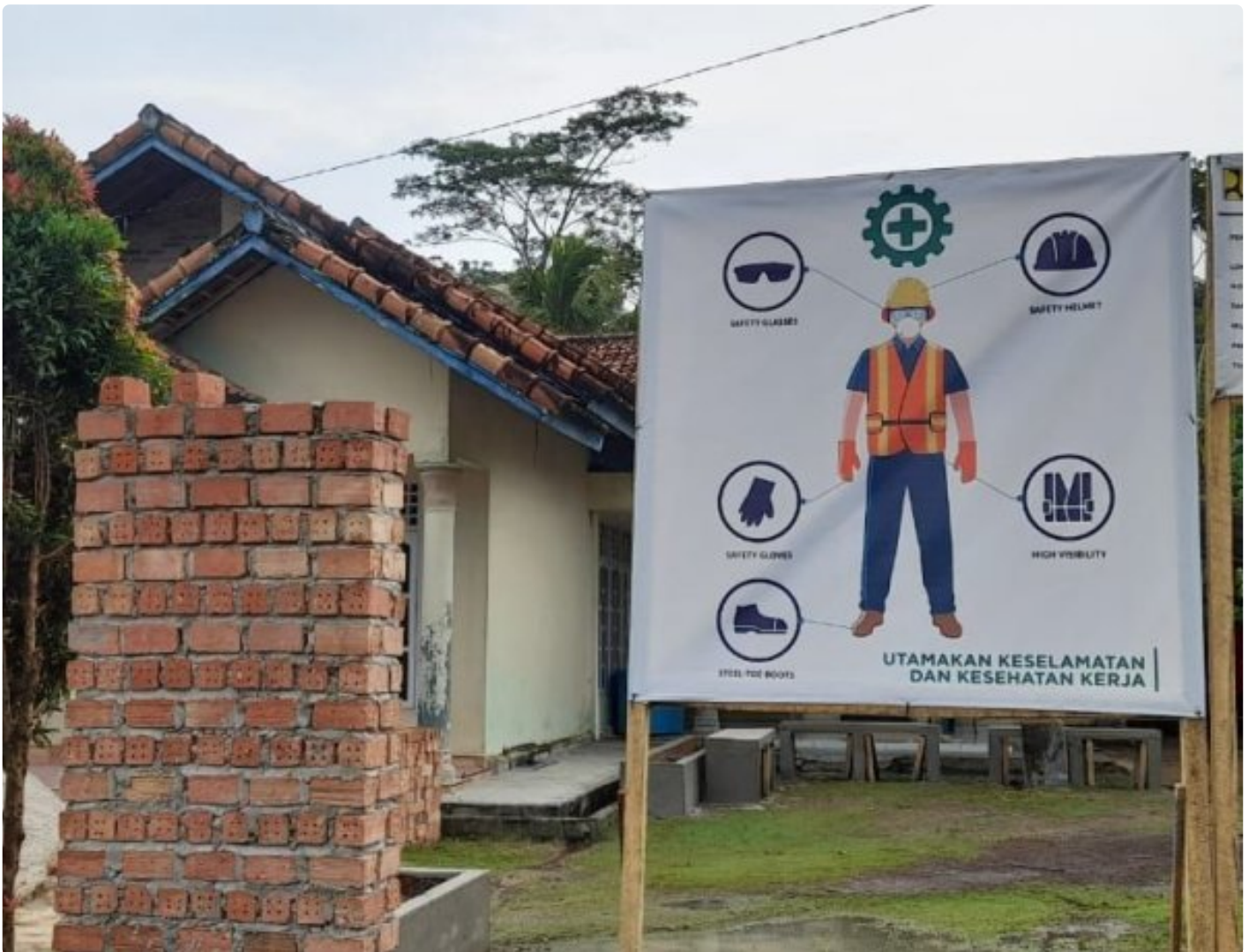
Proyek Infrastruktur Hunian Hijau di Mesuji
